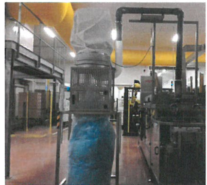
Photo 26 : récupérateur de sachets équipé d'un aspirateur
