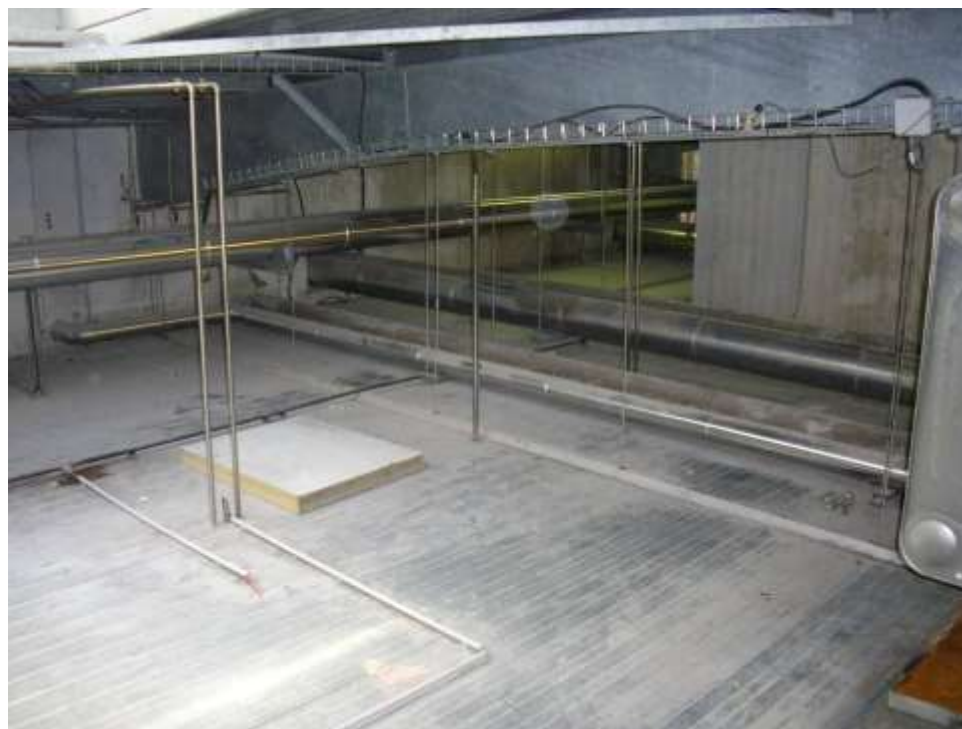
Figure 19 : Combles de l'usine
