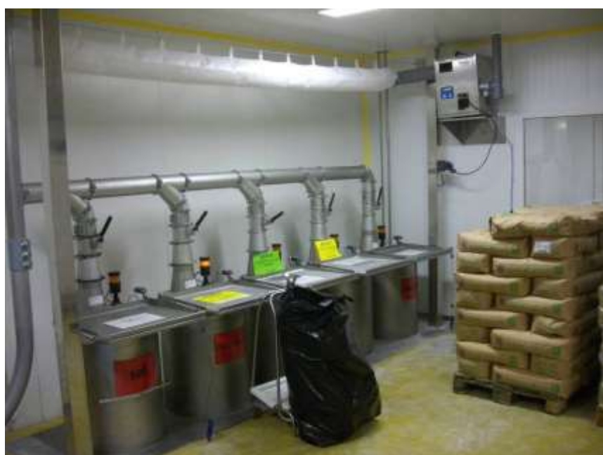
Figure 5 : Salle de charge des ingrédients de l'atelier « viennoiserie 2 »
