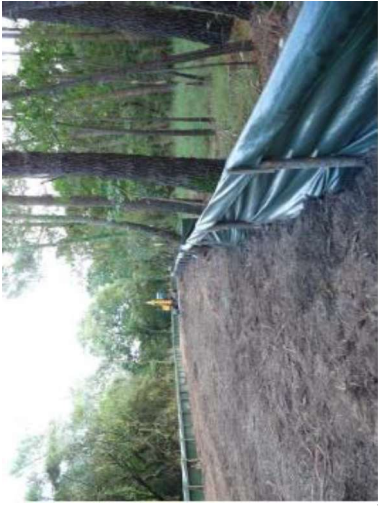
Photo 117 - Exemple de bâches posées pour éviter la traversée du chantier par les amphibiens
