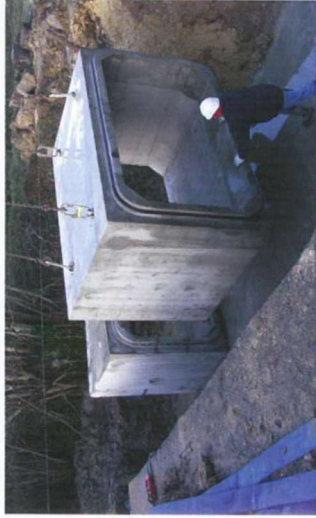
Figure 25- Mise en place de modules préfabriqués sur lesquels un rainurage est effectué pour favoriser l'accueil de chauves-souris (aménagement projeté sur les OH4b, OH4c, OH4d et OH4f) Source : CEREMA, avril 2016 - Chiroptères et infrastructures de transport
