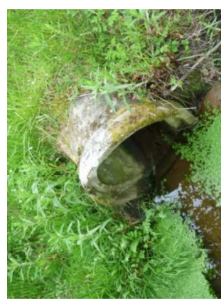
Photo 12 - Buse (OH1b) de diamètre 600 mm
