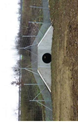
Figure 125- Exemple de passage inférieur (source : CEREMA)
