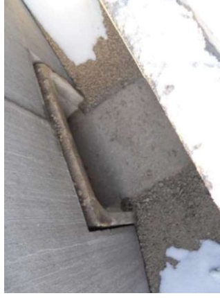
Figure 126- Exemple de batrachoduc (source : CEREMA)
