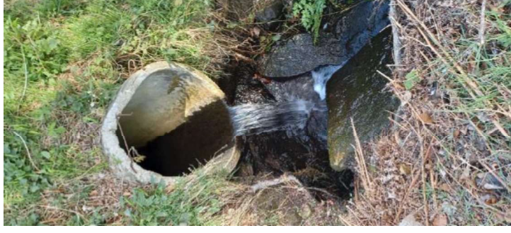
Photo 70- Buse (OH2c) sous la RD775 créant une discontinuité (source : Fédération de pêche 56)
