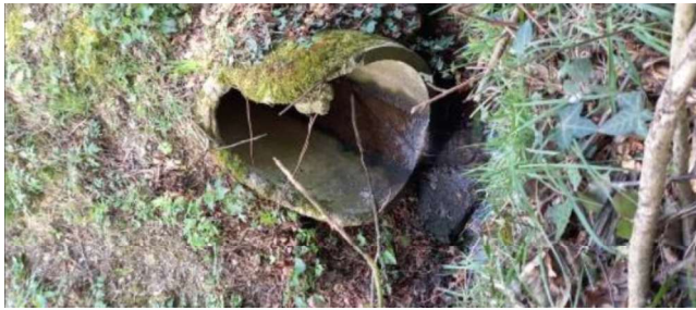
Photo 72- Buse (OH1c) sous la RD775 créant une discontinuité (source : Fédération de pêche 56)
