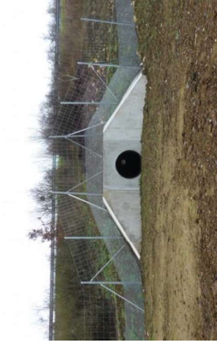
Photo 141- Exemple de passage inférieur (source : CEREMA)
