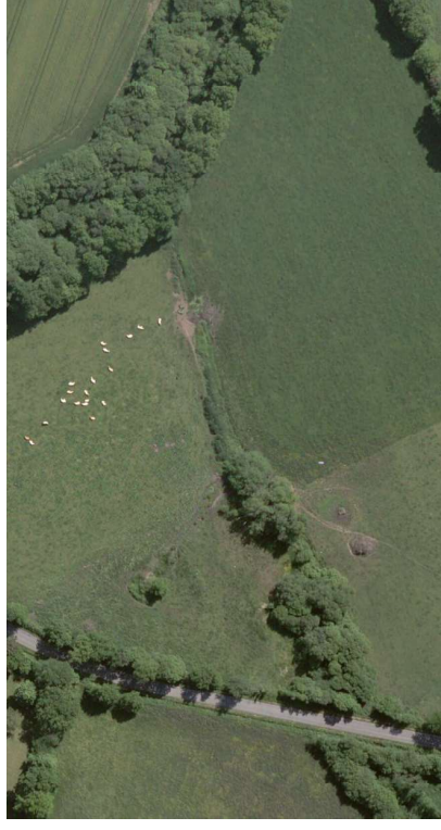
Figure 136- Photographie aérienne du site de Kergrenouille avant le busage en juin 2013 (source : remonterletemps.ign.fr)
