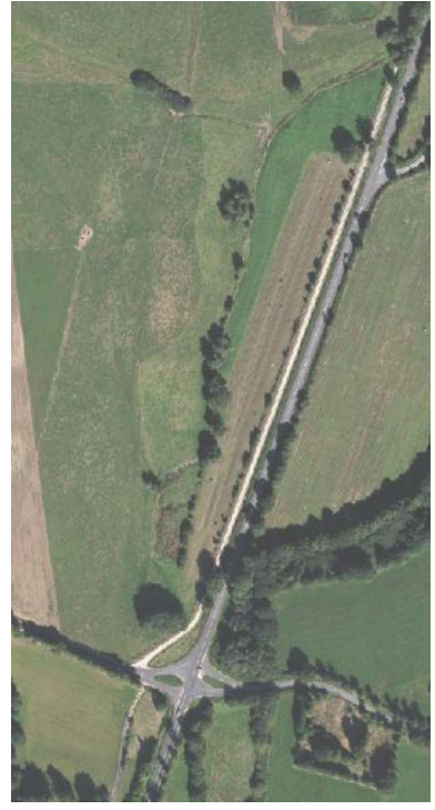
Figure 143- Orthophoto du site de compensation de Port Morgan en 2019 (source : IGN)
