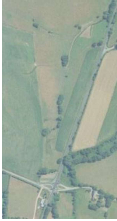
Figure 142- Photographie aérienne du site de Port Morgan après réalisation des fossés de drainage en septembre 1993 (source : remontertemps.ign.fr)
