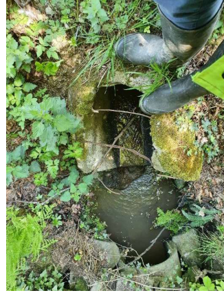
Photo 29- Ouvrage OH1c - amont avant le passage sous talus
