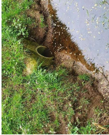
Photo 37- Ouvrage OH5 - aval
