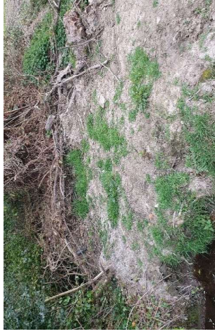
Photo 40- Paratie aval de la buse légèrement remaniée
