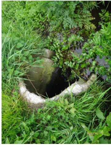
Photo 31- Ouvrage OH2b - amont
