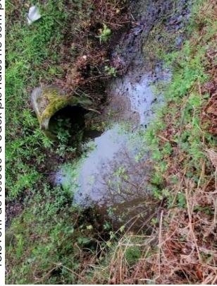
Photo 27- Ouvrage OH1a - amont
