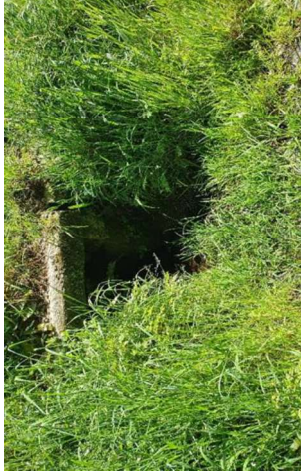
Photo 35- Ouvrage OH4 - amont
