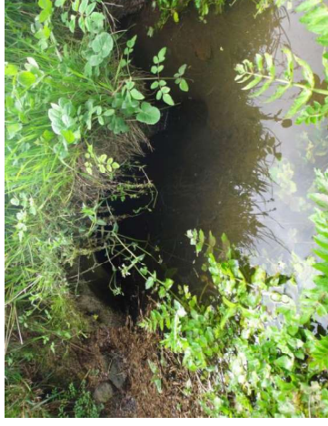
Photo 30- Ouvrage OH2a - amont
