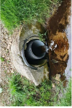
Photo 36- Ouvrage OH4 - aval
