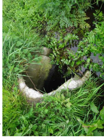
Photo 33- Ouvrage OH3 - amont
