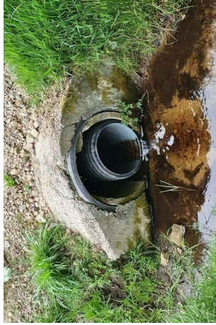
Photo 39- Buse OH4 restaurée et doublée
