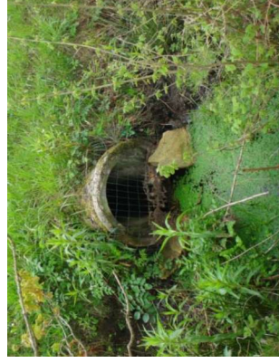
Photo 28- Ouvrage OH1b - amont
